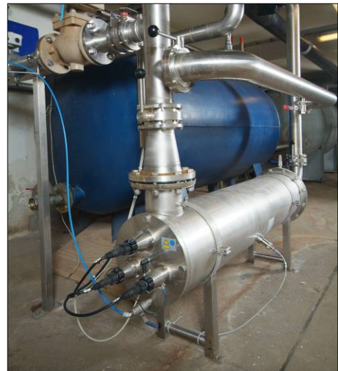
UV-System Typ Spektron 70 mit einem Durchsatz von 108 m³/h. Das System ist in einer Molkerei eingesetzt.
