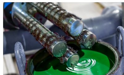
Een magneet in het deeltjesfilter verzamelt efficiënt magnetiet-resten uit het watercircuit.
